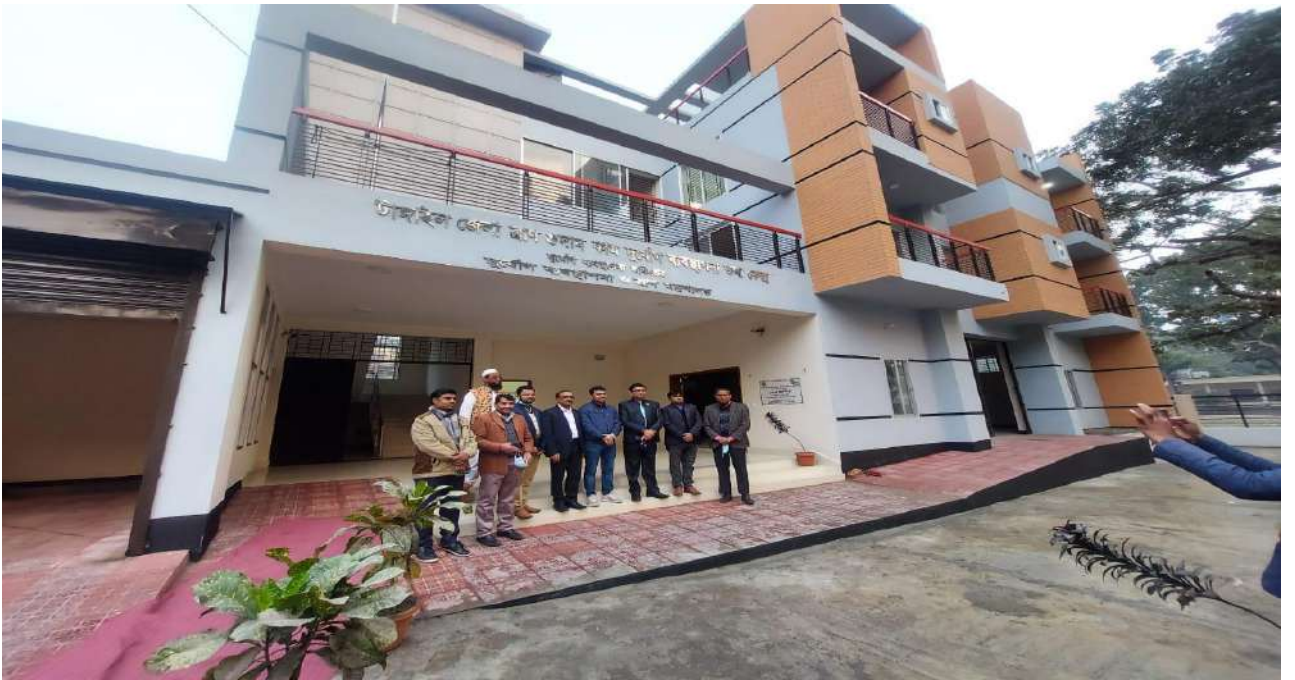
চিত্রঃ ০৪ জনাব নিশ্চিন্ত কুমার পোদ্দার, প্রকল্প পরিচালক, দুর্যোগ ব্যবস্থাপনা অধিদপ্তর, ঢাকা কর্তৃক টাঙ্গাইল জেলা ত্রাণ গুদাম কাম দুর্যোগ ব্যবস্থাপনা তথ্য কেন্দ্র নির্মাণ প্রকল্প পরিদর্শন।
