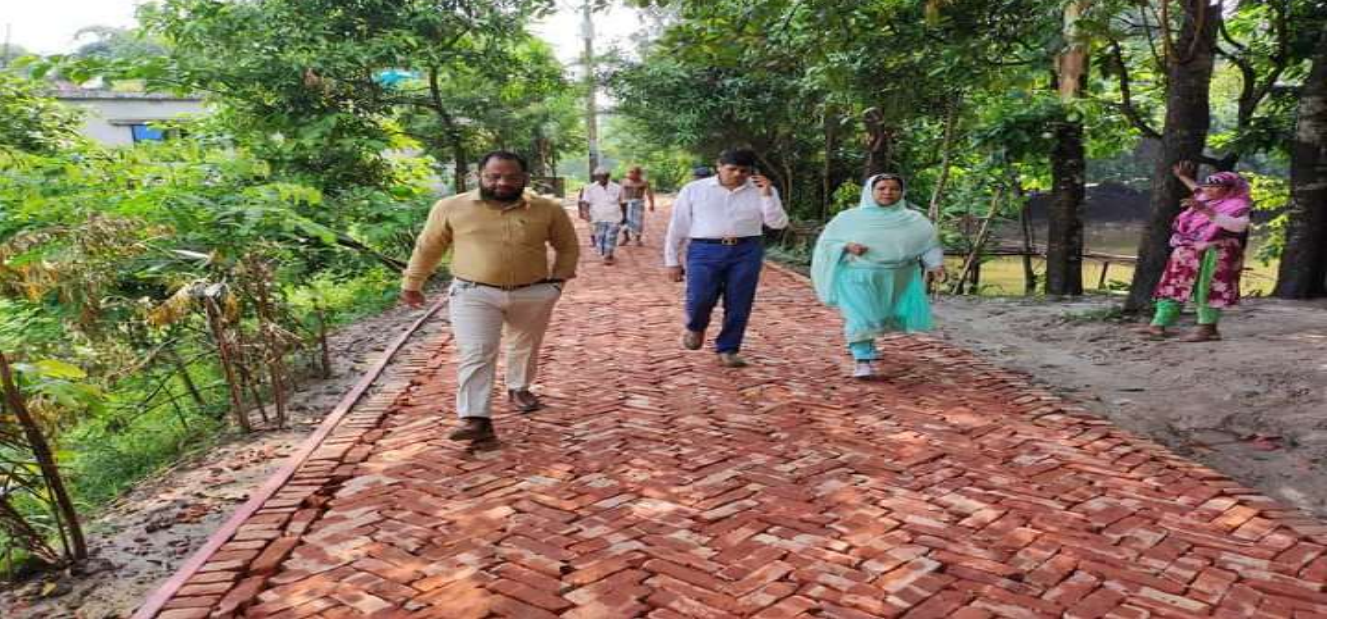
চিত্রঃ ০৩ উপপ্রকল্প পরিচালক, সহকারী প্রকৌশলী ও উপজেলা প্রকল্প বাস্তবায়ন কর্মকর্তা কর্তৃক ২০২১-২০২২ অর্থ বছরে মুন্সিগঞ্জ জেলার লৌহজং উপজেলায় খিদিরপাড় ইউপির পিংনালী পাকা রাস্তার মোড় হতে মালনী জামে মসজিদ হয়ে ফুলকচি সীমবাগ পর্যন্ত রাস্তা হেরিং বোন বন্ড (এইচবিবি) করণ এবং গাওদিয়া ইউপির পশ্চিম পালগাঁও জামে মসজিদের নিকট পাকা ব্রীজের সামনে থেকে তিন রাস্তার মোড় পর্যন্ত রাস্তা হেরিং বোন বন্ড (এইচবিবি) করণ প্রকল্প পরিদর্শন।
