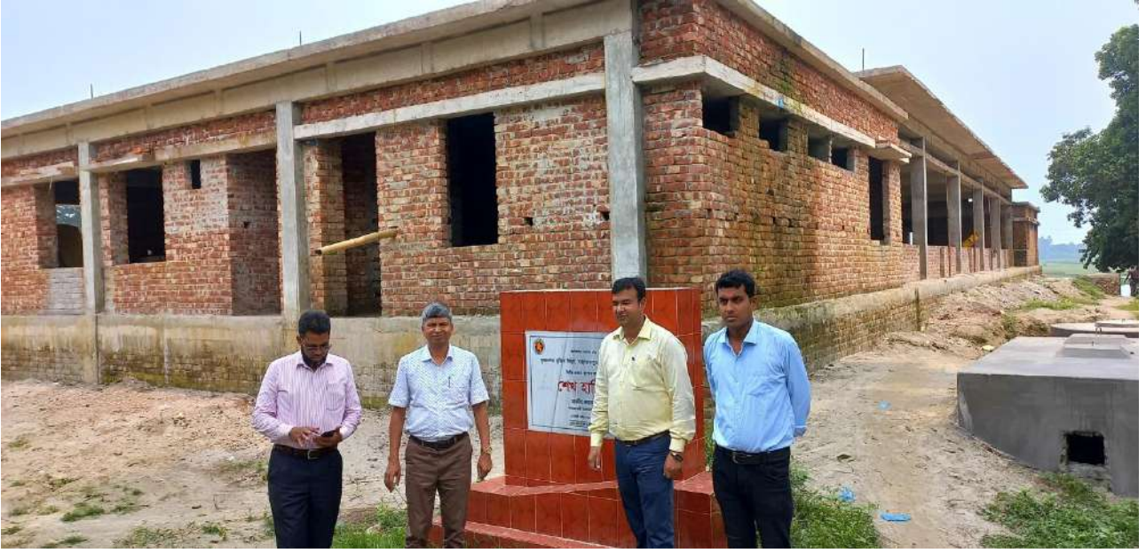
চিত্রঃ ০৫ ডা. সঞ্জীব সূত্রধর (উপসচিব), উপপরিচারক (বাজেট ও হিসাব), দুর্যোগ ব্যবস্থাপনা অধিদপ্তর কর্তৃক কৃষ্ণনগর, বাঞ্ছারামপুর, ব্রাহ্মণবাড়িয়ায় নির্মাণাধীন মুজিব কিল্লা পরিদর্শন।
