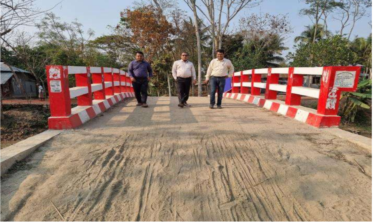
চিত্রঃ ০৩ জনাব মোঃ শফিকুল ইসলাম, প্রকল্প পরিচালক, গ্রামীণ রাস্তায় ১৫মি. পর্যন্ত সেতু/কালভার্ট নির্মাণ প্রকল্প, দুর্যোগ ব্যবস্থাপনা অধিদপ্তর কর্তৃক গোপালগঞ্জ জেলার কোটালীপাড়া উপজেলায় নির্মিত সেতু পরিদর্শন।
